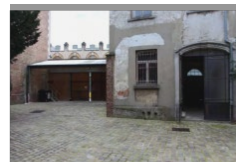
Bâtiment n°57 et parcelle non-bâti depuis la cour des Archives
