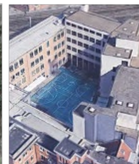
Toitures de l'école Charles-Gheude
