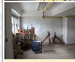
Locaux de la tour E au rez-de-chaussée
